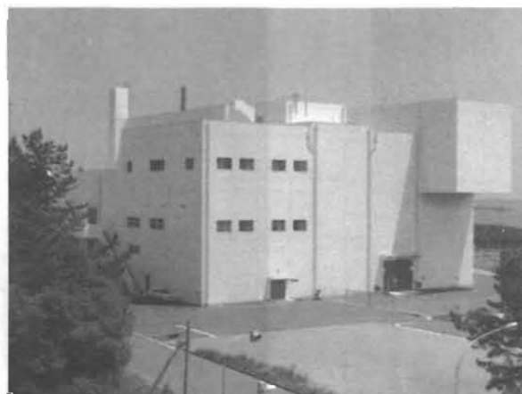
解体分別保管棟全景
