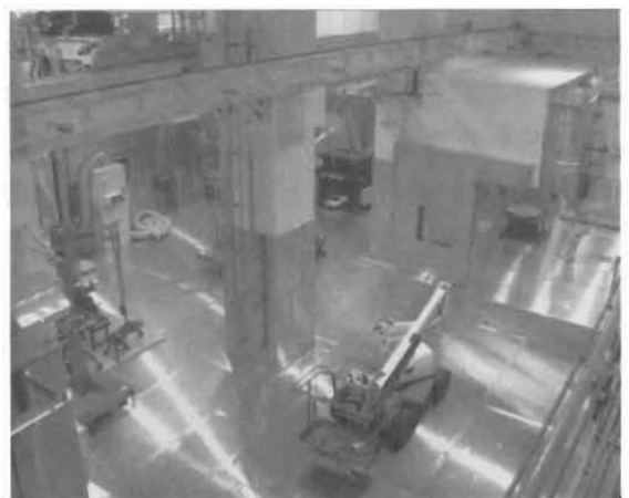
解体室 (解体エリア)
